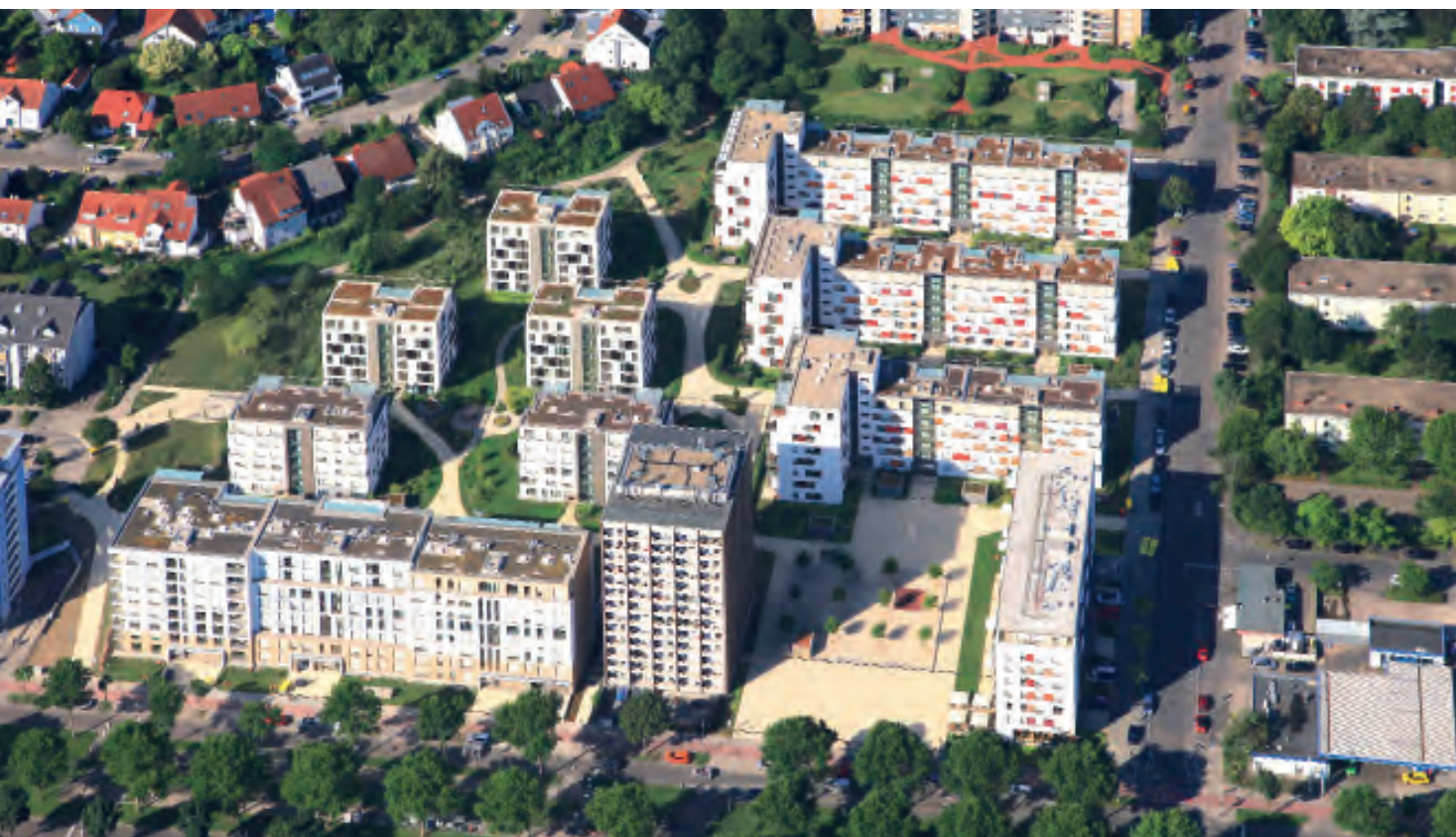
Gesamtentwicklung Wohnpark Niederfeld, Mannheim Gartenansicht und Luftaufnahme
