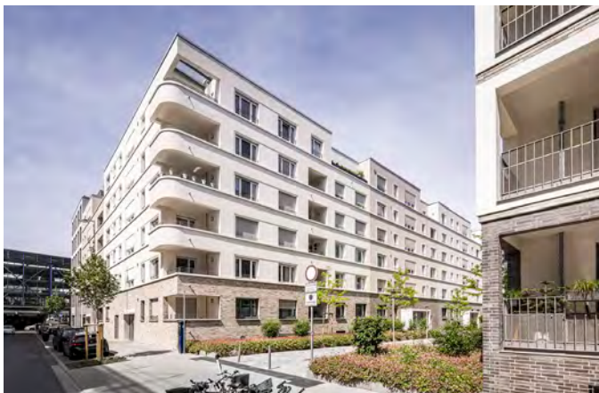
KEPLER-Quartier auf dem ehemaligen Postareal in Mannheim Wohnen, Büro und Luftbild der Baustelle
