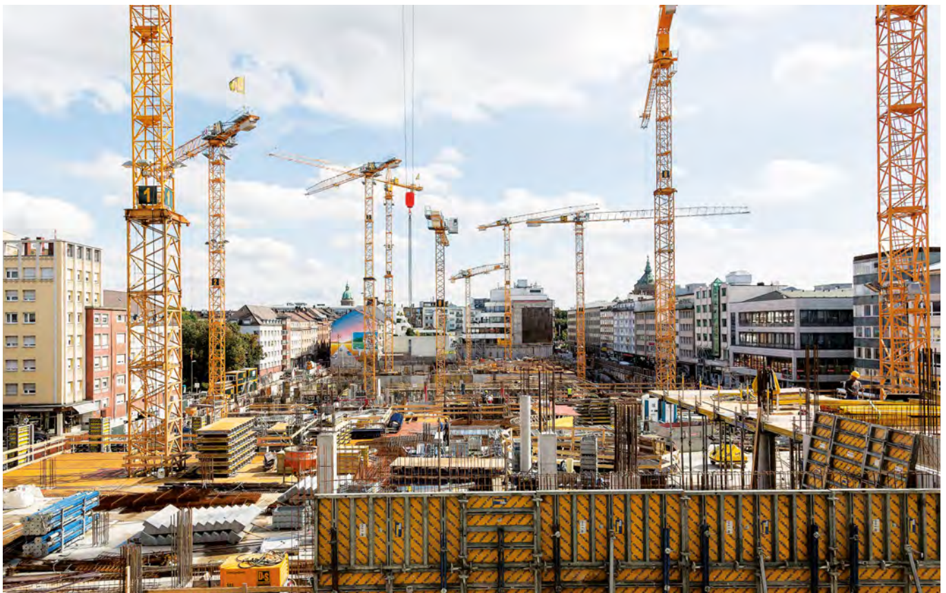
Baustelle des Innerstädtischen Quartiers Q 6 Q 7, Mannheim
