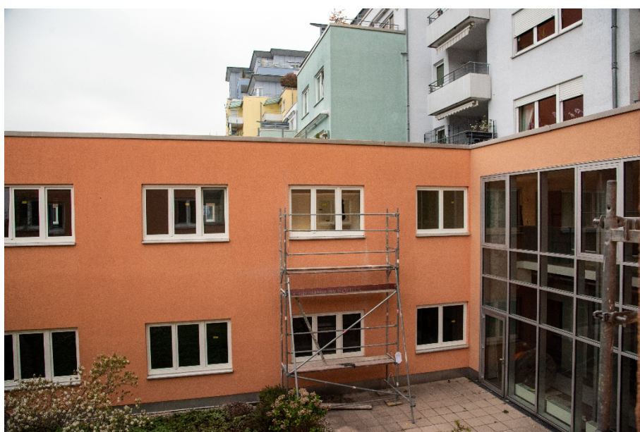
Die Aufenthaltsräume der Wohnbereiche im ersten Obergeschoss erhalten in den kommenden Wochen noch vorgelagerter Balkone.
