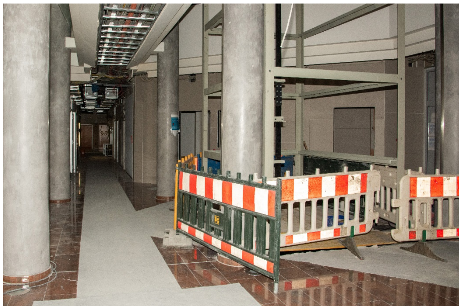
Im einstigen Hotelfoyer wird der speziell als Glas-Stahlkonstruktion gefertigte Bettenaufzug integriert.
