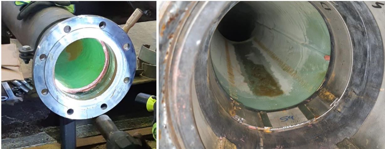
Bild 19 Neusetzen der Manschetten mit Harzabdichtung bei „Esders HPS Liner“ : Einbringen des Dichtmittels (links), Nacharbeitsergebnis (rechts)
