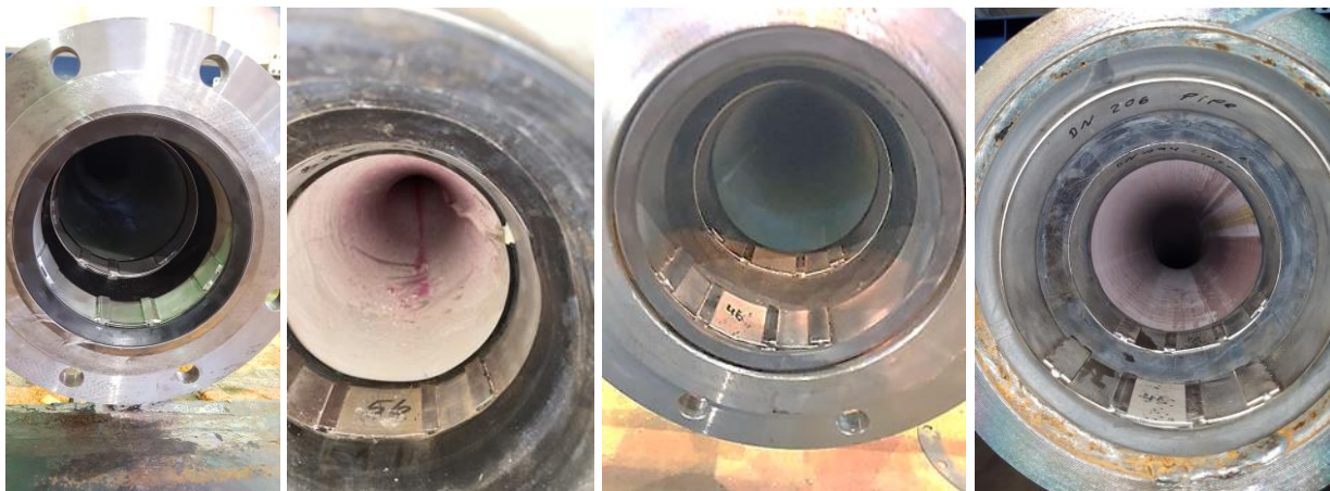
Bild 41 Liner-End-Manschetten von links: „Starline Structure-S“ (Kempe), „SaniPipe“ (Amex), „Esders HPS Liner“ (Amex) und „Nordiflow W PE“ (Amex)
