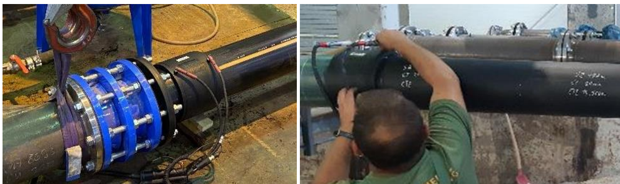
Bild 40 PE-Flansch-/ Elektroschweißmuffen: „egeLiner“ (links) und „Compact Pipe“ (rechts)
