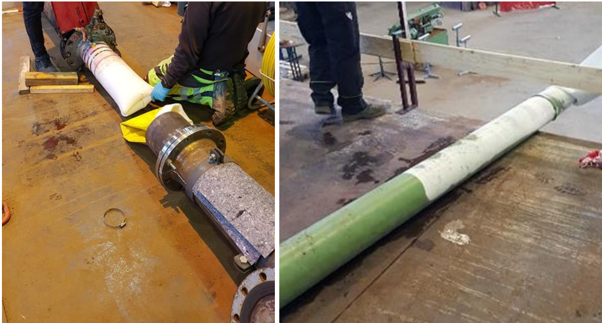
Bild 38 Einzieh- und Inversionsverfahren: „SaniPipe“ (links) und „Esders HPS Liner“ (rechts)
